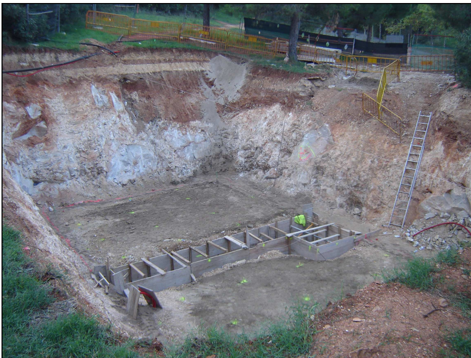
Vista final dels rebaixos al dipòsit
