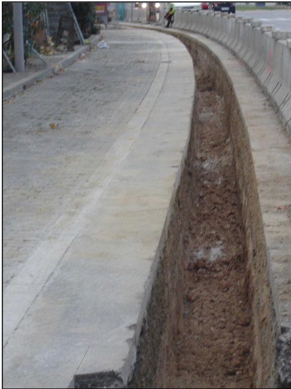
Vista final del rebaix realitzat entre els metres 357 i 452 del tram 3.
