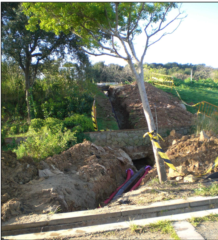
Vista del mur u.e.23
