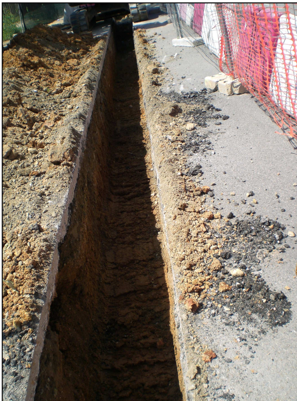
Vista del tram 2a de la rasa ja rebaixat
