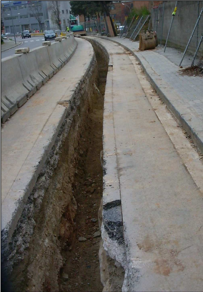
Vista final del rebaix en la part asfaltada del Tram 4.
