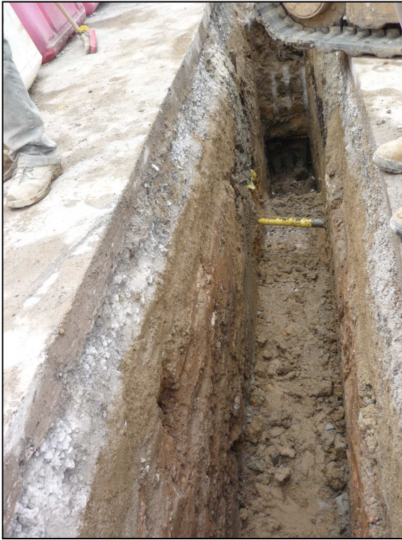
Vista de la part final del Tram 4
