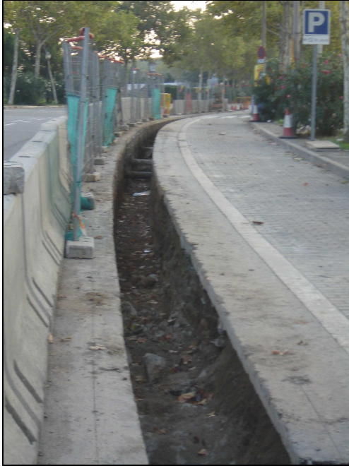
Vista final rebaix rasa entre els 120 i 231 metres
