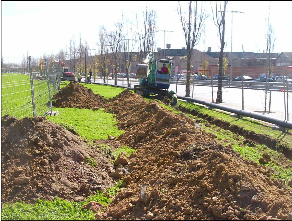
Vista dels treballs de rebaix de la rasa a la zona de parterre del carrer Mare de Déu de Port
